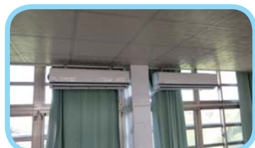
各班級冷氣裝設
