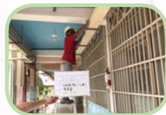
電力系統改善施工
